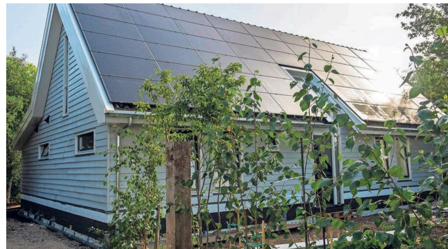
De zuidkant van het dak is een vlak bestaande uit zonnepanelen.
